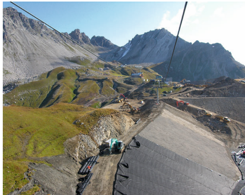
Speichersee beim Pfannenkopf, Bauarbeiten 2008 (Baubüro Gamprin)
