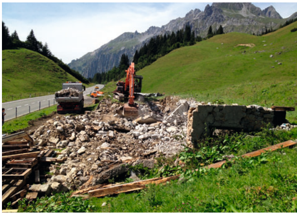
Schuler Stall, Abbruch 2012 (Baubüro Gamprin)
