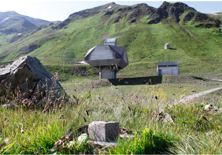
Lüftungsschacht Arlberg Strassentunnel mit Grenzstein zur Alpe Albona 2013 (Mathias Heeb)
