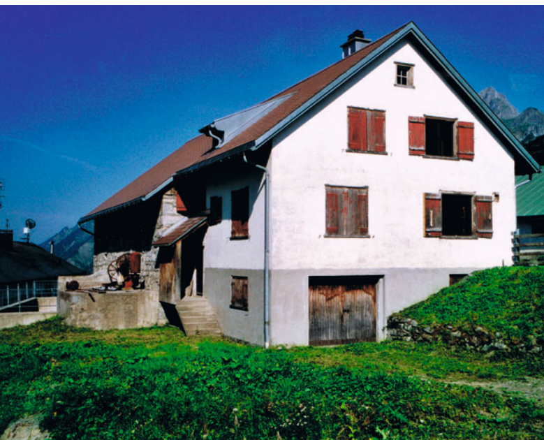
Unteres Alpgebäude Rauz vor der Sanierung 2004 (Adolf Marxer)
