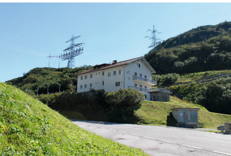
Personalhaus der Arlberger Bergbahnen mit Fernleitungsmasten 2012 (Franz J. Heeb)
