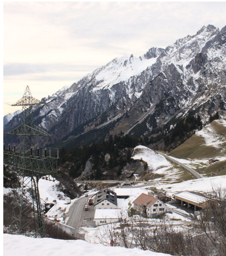
Bauhof und Alpgebäude Rauz im November 2013 (Franz J. Heeb)
