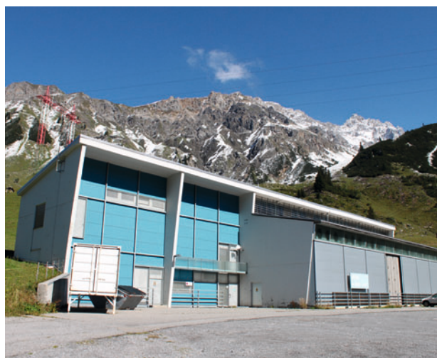
Umspannwerk Rauz der Vorarlberger Kraftwerke 2012 (Franz J. Heeb)
