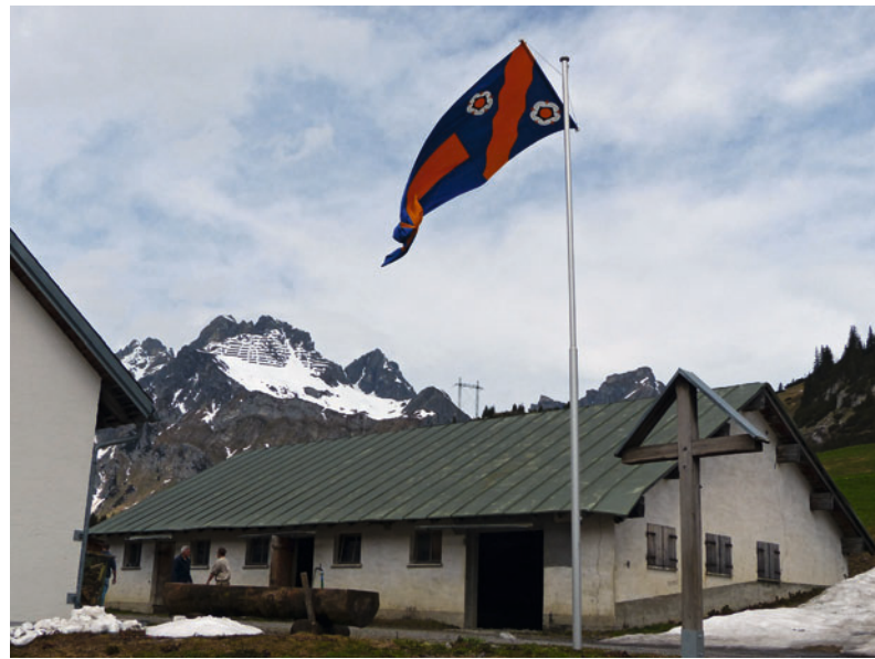
Oberer Alpstall vor dem Abbruch 2013 (Baubüro Gamprin)
